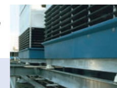
■ Trillingsdempers voor koeltorens RAI-Amsterdam
