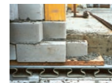
■ Doos in doos constructie Jongerencentrum Tavenue-Waalwijk
