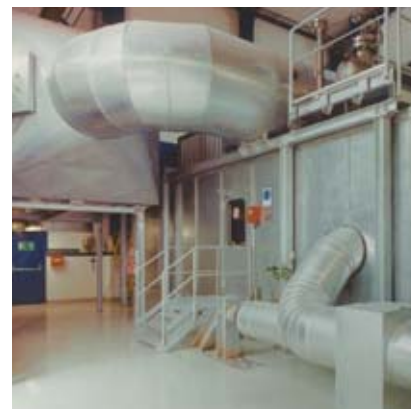
Schallschutzkapsel mit Ansaug-, Abgas- und Lüftungssystem; Solar Centaur, Gaskompressorstation, Karlsruhe, Deutschland
