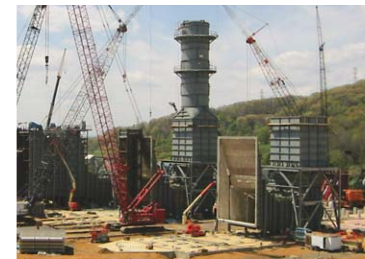
Montage Gasweiche und Bypasskamin für Gasturbinenkraftwerk, Siemens V84.2, Connecticut, USA
