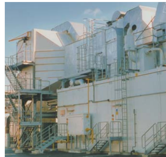
Schallschutzkapsel mit Ansaug- und Lüftungssystem; GE Frame 6B, GuD-Anlage, BASF Schwarzheide, Deutschland
