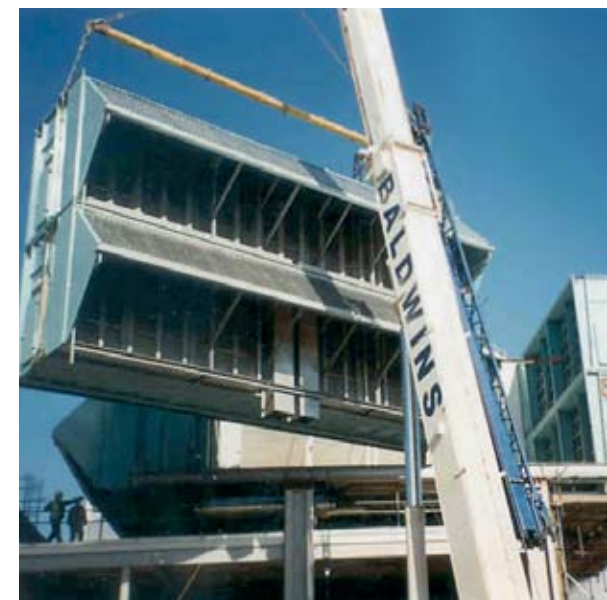
Montage eines Gasturbinen-Filterhauses, Siemens V94.3A2, Peterhead, Schottland
