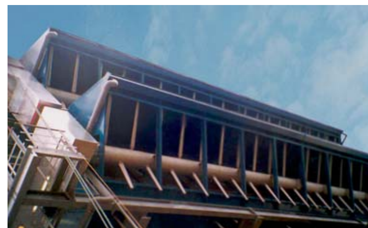
Filterhaus für Gasturbinenkraftwerk, Siemens V94.3A2, Peterhead, Schottland
