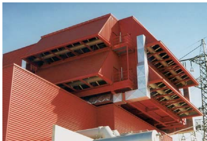
Filterhaus für Gasturbinenkraftwerk, Siemens V94.3A2, Theiss, Österreich
