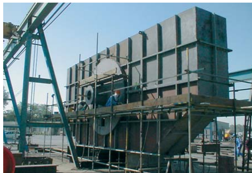
Herstellung eines Gasturbinen-Einlaufunterteils, Siemens V94.3A2
