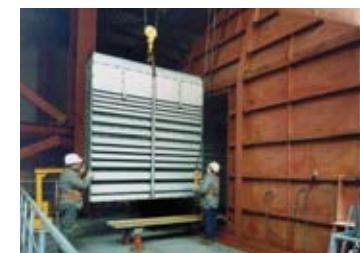
Montage von Resonatorkullissen, Kohlekraftwerk, Jämschwalde, Deutschland
