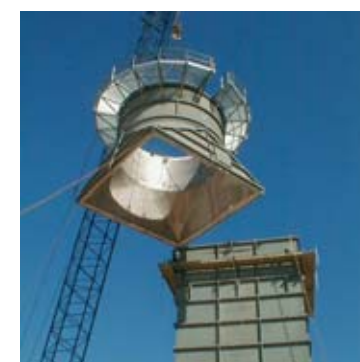
Montage eines Gasturbinen-Abgaskamins, V84.2, Holden, USA
