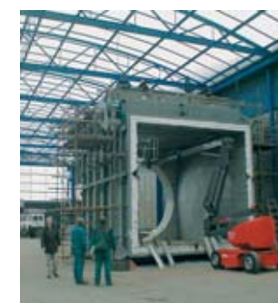
Probemontage einer Abgas-Gasweiche, Siemens V84.2
