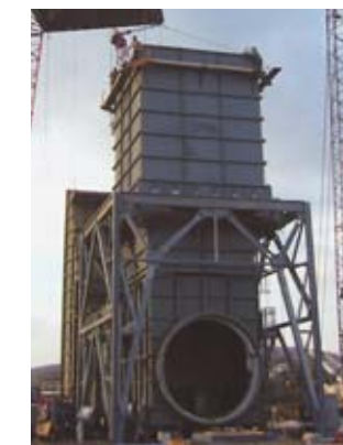
Gasweiche für Gasturbinenkraftwerk, Siemens V 84.2, Connecticut, USA
