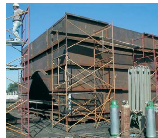
Herstellung einer Abgas-Umlenckecke, Siemens V84.2
