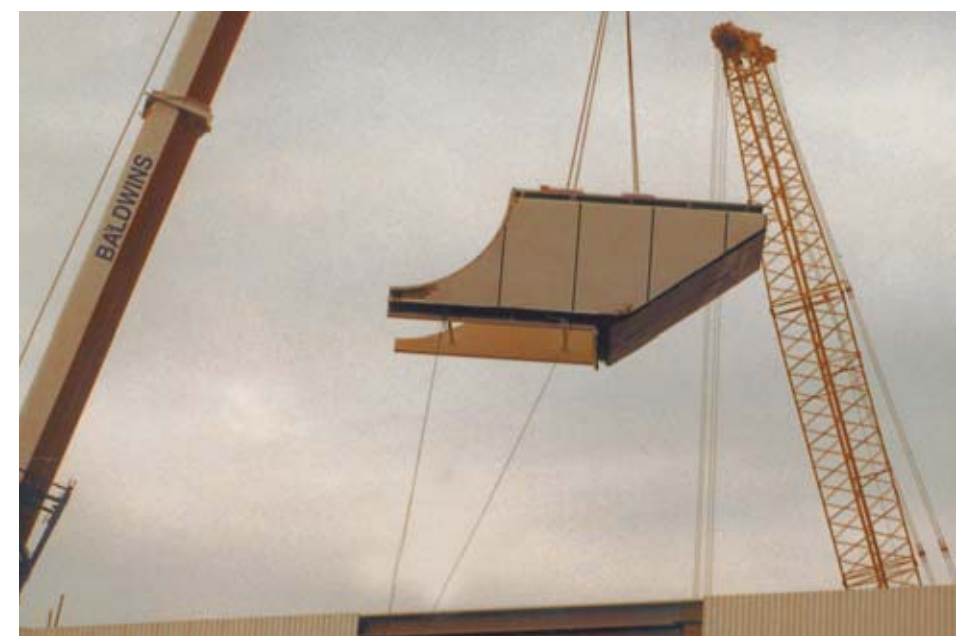
Einheben eines Gasturbinen-Ansaugkanalteils, Siemens V94.3A2, Peterhead, Schottland
