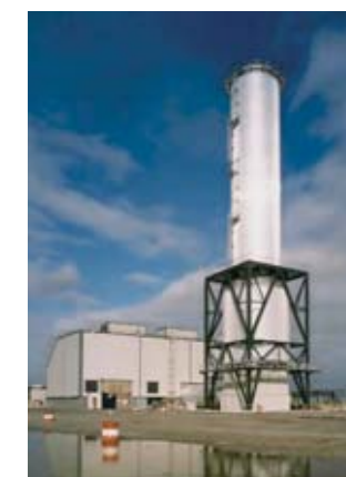
Gasweiche für Gasturbinenkraftwerk, Siemens V 84.2, Connecticut, USA
