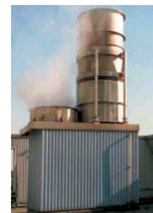
Dampf-Ausblaseschalldämpfer MVA Oberhausen, Deutschland
